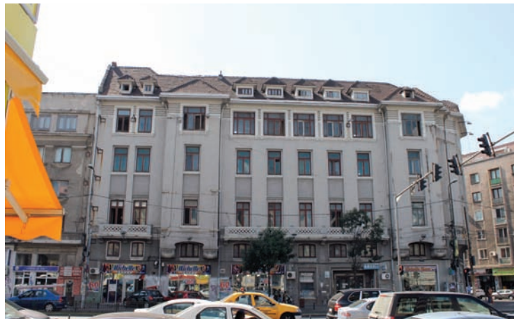
Clădirea înainte de începerea lucrărilor, iunie 2011
