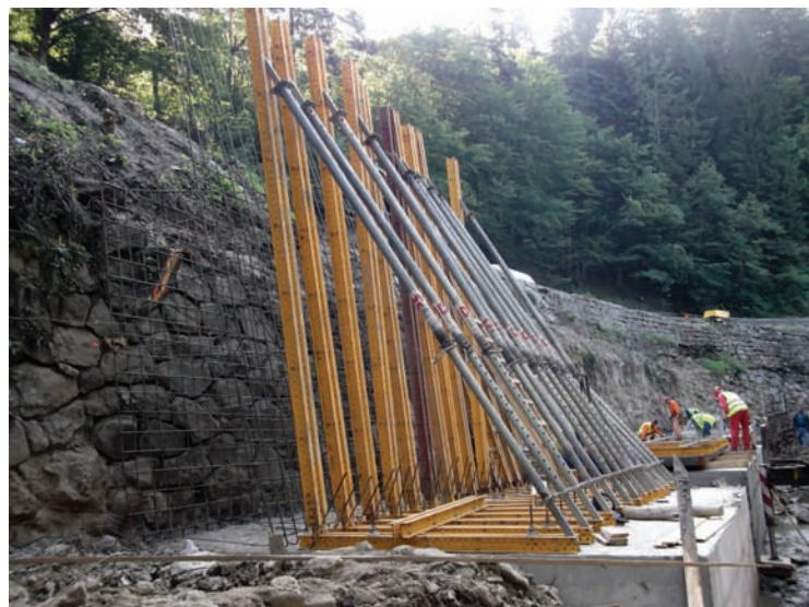
Zid de sprijin Oituz
