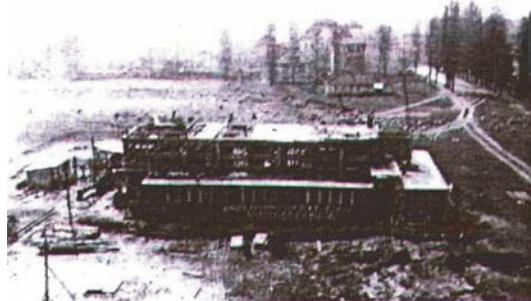
Aspect din faza de construcție
