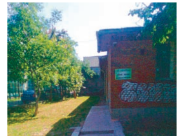
Hala 1 de încercări materiale pentru construcții
