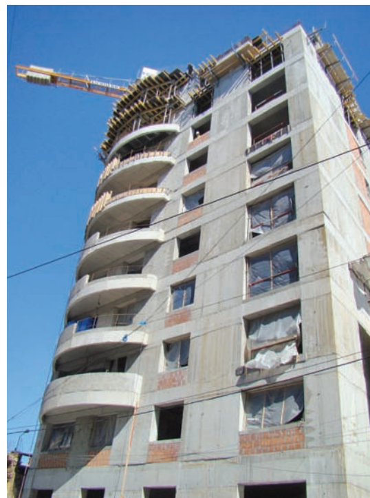
Bloc pe strada Maria Rosetti, realizat de Trei Lacuri Invest.
