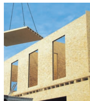
Construcție de tip modular cu EUROSTRAND® OSB/3
