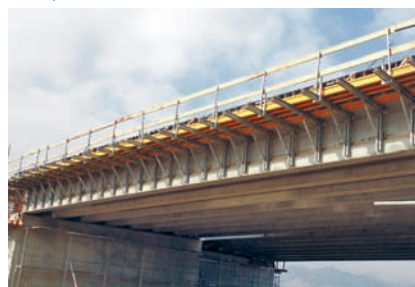
Exemplu de cofrare a consolei de trotuar
