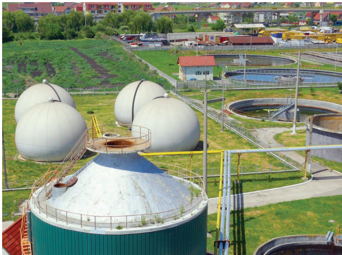
Extinderea și modernizarea infrastructurii de apă și apă uzată, Bistrița
