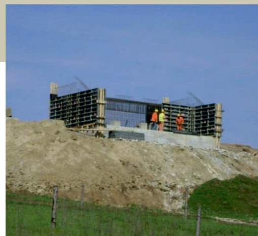
Cofrajul ușor Rasto a reprezentat soluția ideală utilizată pentru construcția culeelor, având în vedere înălțimile mici ale acestora dar și coeficientul ridicat de manevrabilitate al acestui tip de echipament.
