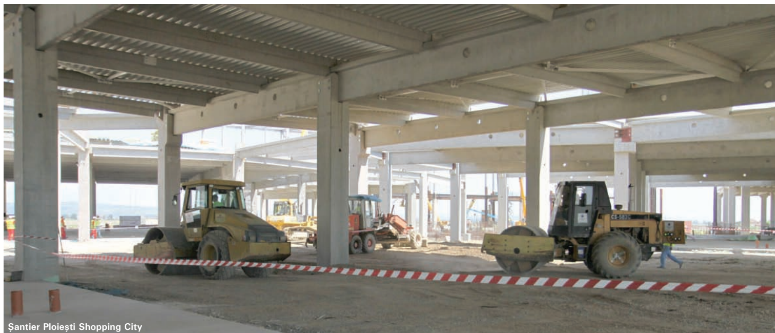
Șantier Ploiești Shopping City
