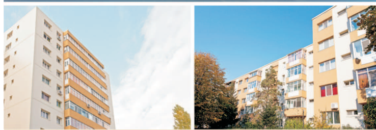
Reabilitare termică imobile - București și Ploiești.
