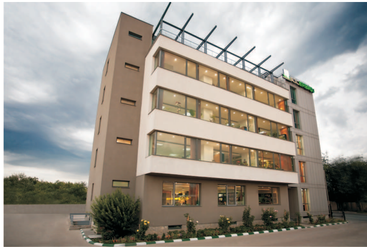
Centrul Logistic - SCC ERBAȘU - Uverturii
