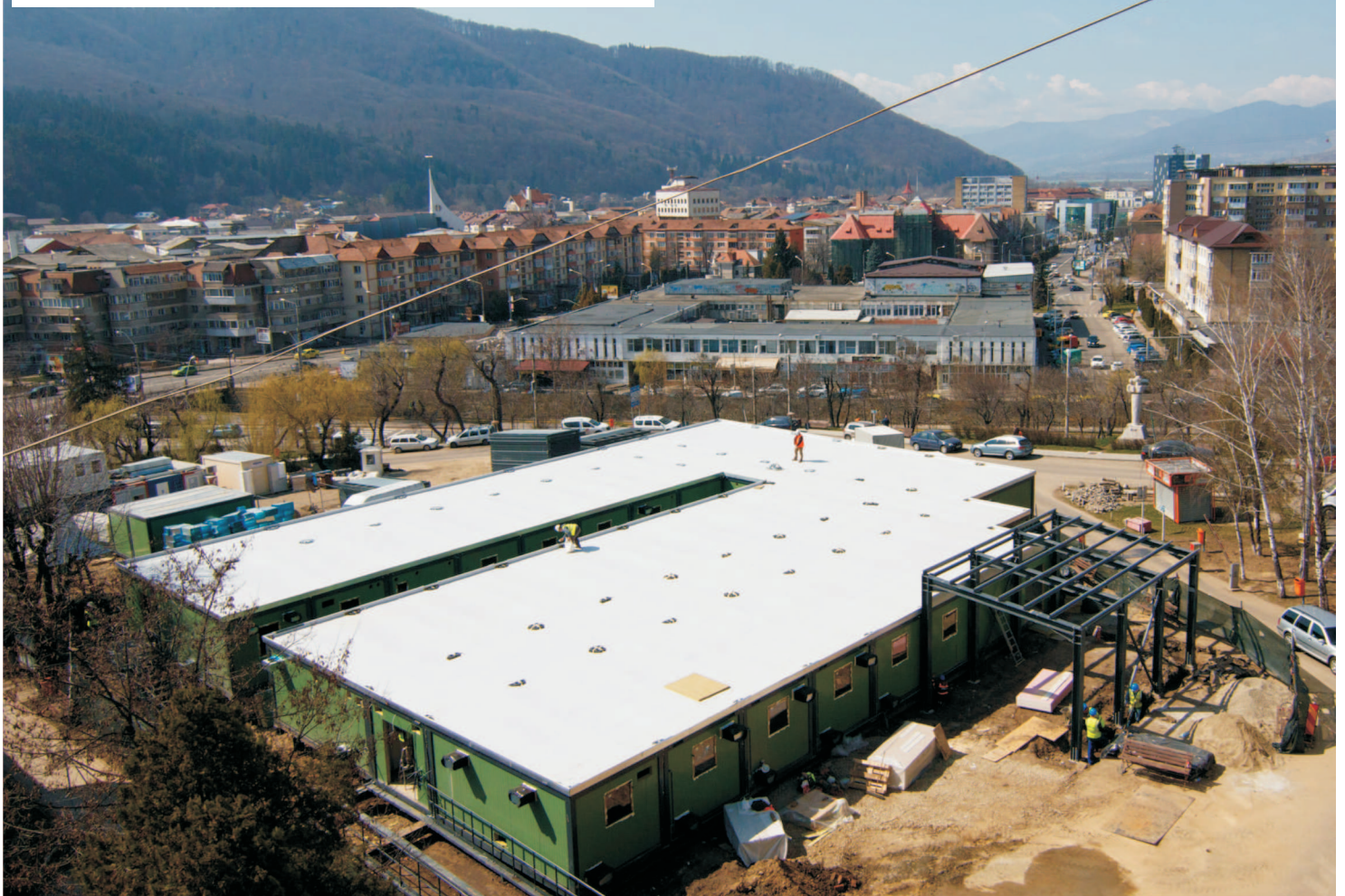
Spitalul Modular ATI Piatra Neamț
