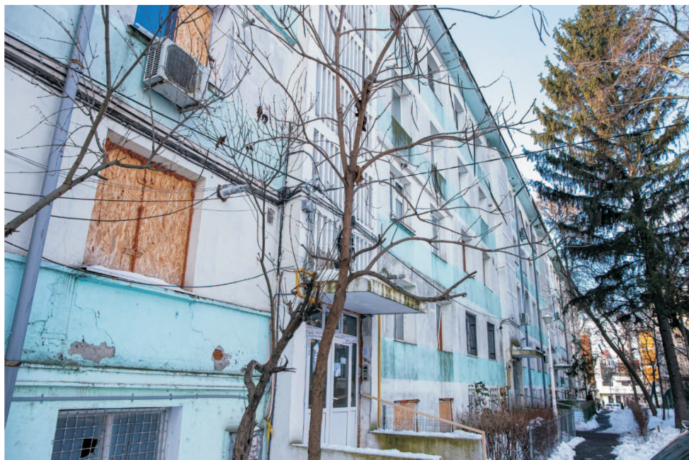
Blocul N6, afectat de o explozie puternică în urmă cu circa doi ani, va beneficia de lucrări ample de renovare, după ce a fost semnat, în cadrul PNRR, contractul de finanțare. Obiectivul specific al proiectului constă în renovarea integrată (consolidare seismică și renovare energetică moderată) a blocului N6, str. Domnească nr.16, Centru, Asociația de Proprietari nr.104 din municipiul Galați.
