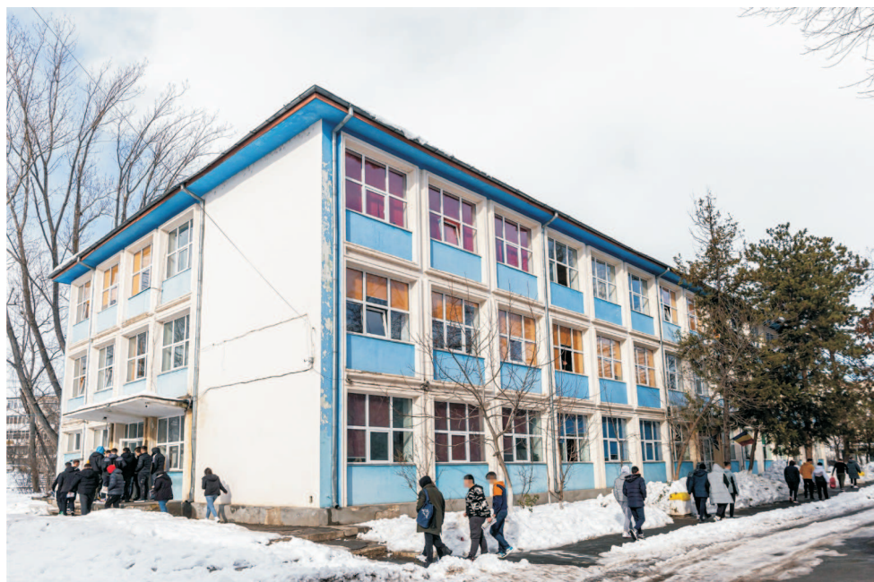
Proiectul Renovarea energetică a Liceului Tehnologic Paul Dimo (corpurile C1, C5, C10, C12), în valoare de 19.752.282,56 lei (3.950.456,512 euro), se adaugă altor proiecte importante ale Primăriei municipiului Galați.
