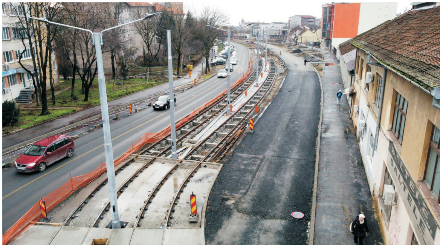
Bulevardul Cetății - reabilitare linii tramvai
