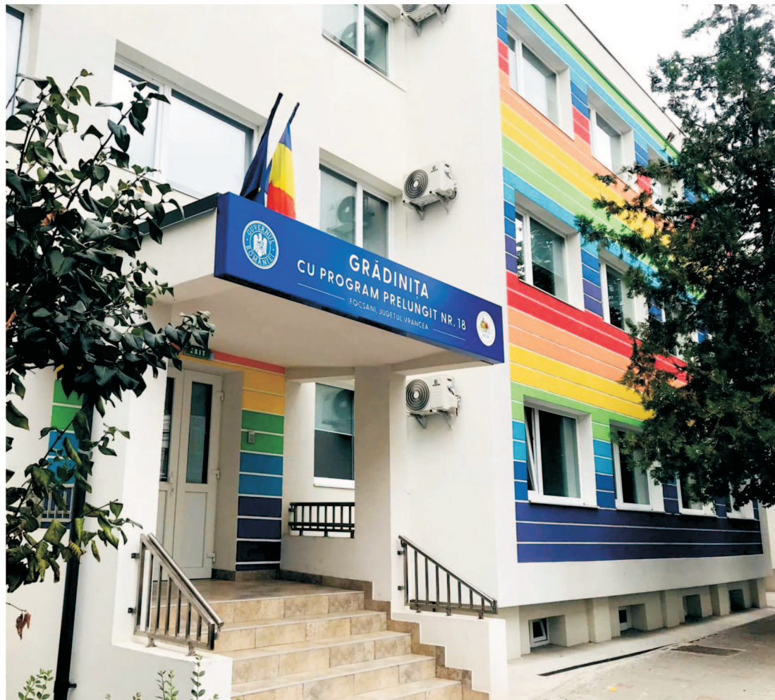
Județul Vrancea , Municipiul Focșani / Numele proiectului: Reabilitare, modernizare clădiri și echiparea infrastructurii educaționale a Grădiniței cu Program Prelungit nr. 18
